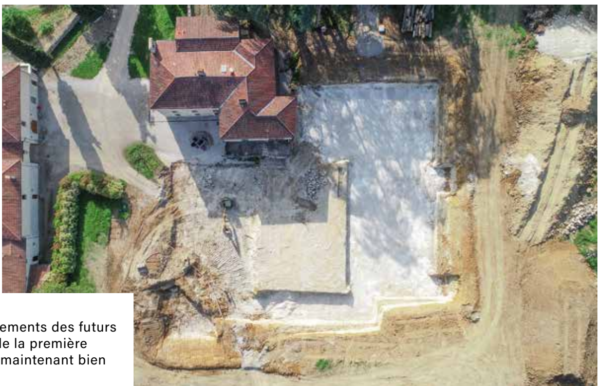
Les camions déversent la terre et le calcaire des terrassements en contrebas de la grange, afin de reprofiler le terrain et créer un nouveau chemin.
