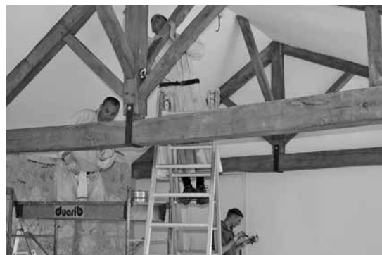
Peinture et électricité au noviciat
